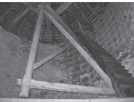
Échelle tournante du pigeonnier ▲
