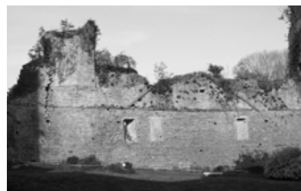
Courtine sud-ouest avant travaux (2006)
