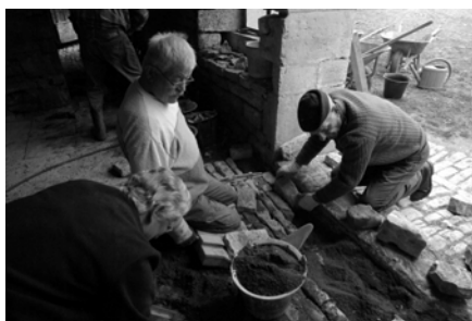
Pose de pavés dans l'entrée de l'étable
