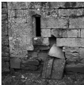
Exemples de désordres dans les parements de la "viorbe"
