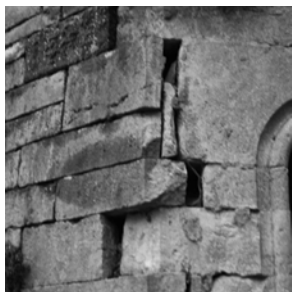
Exemples de désordres dans les parements de la "viorbe"
