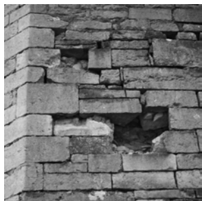
Exemples de désordres dans les parements de la "viorbe"
