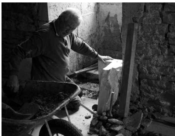
Pose de dalles de sol dans les baies du "Logis nord"
