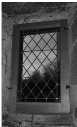
La "viorbe" : châssis fixe en cours de pose (décembre 2015)
