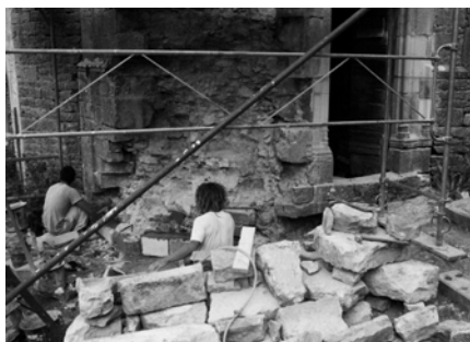
La "viorbe" : restauration des maçonneries de façade (juillet 2015)
