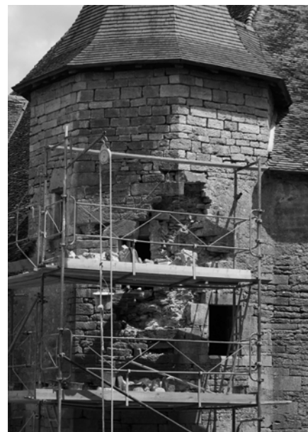
La "viorbe" : restauration des maçonneries de façade (juillet 2015)
