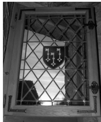
La "viorbe" : pose du châssis ouvrant au dessus de l'entrée (décembre 2015)
