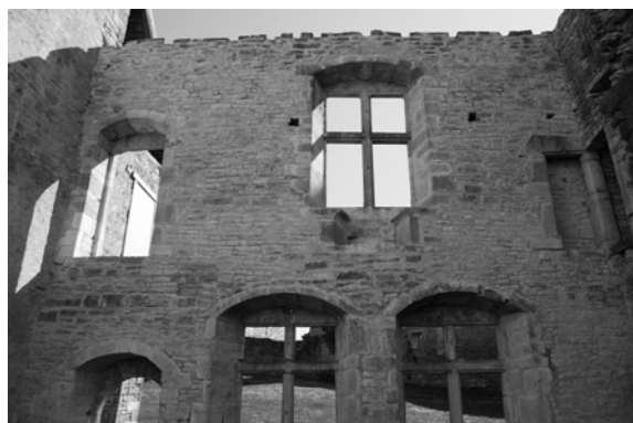
Parement intérieur, joints terminés
